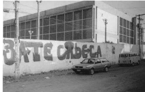
Fig. 3 Vista Externa Crédito: Autor
