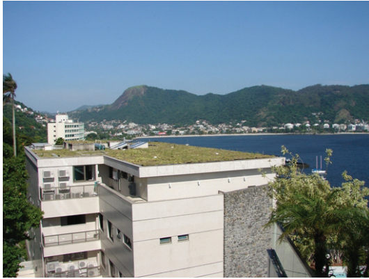
Figura 10 – Cobertura verde Sistema Alveolar - RJ Fonte: www.ecotelhado.com.br
