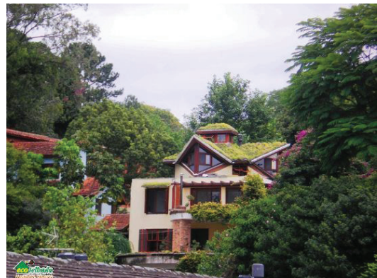
Figura 03 – Residência em Porto Alegre/RS Fonte: www.ecotelhado.com.br
