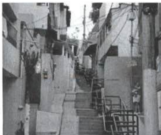
Escadaria Manoel Antonio Pinto, Antonico, após as obras de urbanização.
