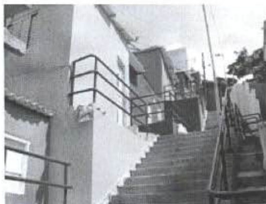
Escadaria do Jd Colombo. Obras de readequação das unidades habitacionais.
