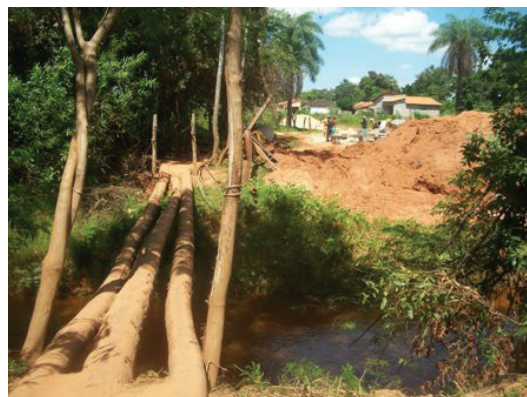
Figuras 2 e 3: passarelas improvisadas em zona urbana e rural.
