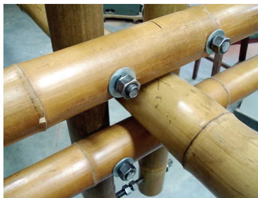
Figura 8 e 9: uso de parafusos em estruturas de grande porte.
