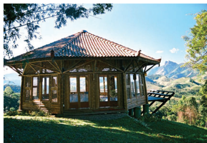
Figuras 15 e 16: estrutura de sustentação e quiosque: ampla utilização de bambu.
