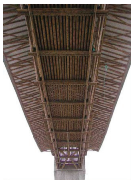
Figuras 19 e 20: Estrutura de bambu, com apoios de concreto nas duas extremidades da passarela.
