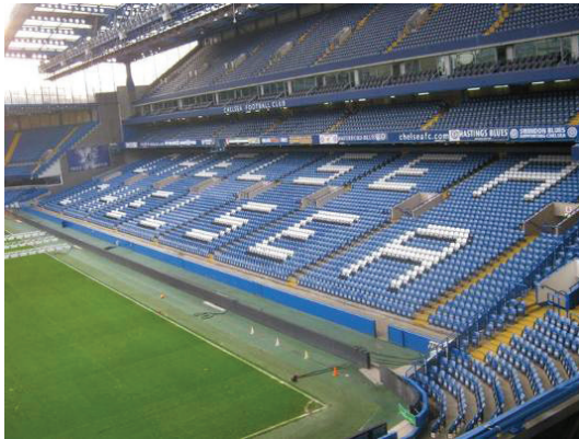
Interior do estádio Stanford Bridge
