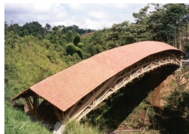
Figuras 21, 22 e 23: Confeção de passarelas de grande porte, utilizando o bambu como estrutura principal, e com cobertura de telha de barro cozido (cerâmicos).
