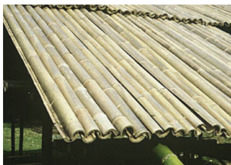
Figuras 13 e 14: uso de bambu na armação do telhado, inclusive usado como telha (cava e capa).
