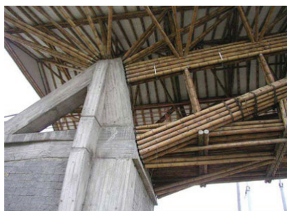
Figuras 17 e 18: construção de ponto de ônibus, utilizando estrutura de bambu.
