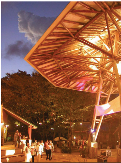
Figuras 4 e 5: grande construção com estruturas de bambu, Colômbia.
