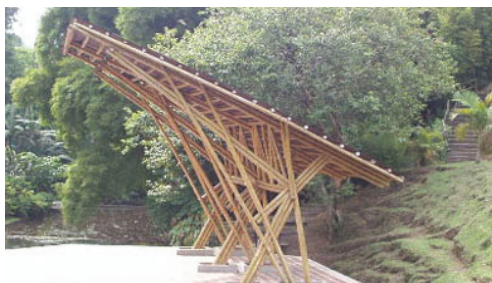
Figuras 17 e 18: construção de ponto de ônibus, utilizando estrutura de bambu.
