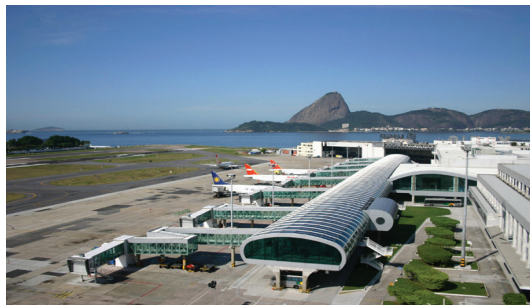
Figura 10 – Vista aérea do conector do terminal de embarque do Aeroporto Santos Dumont
