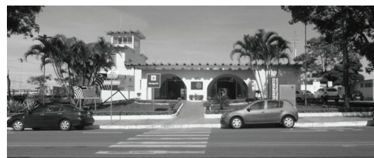
Figura 01– Vista externa do Aeroporto de Marília.
